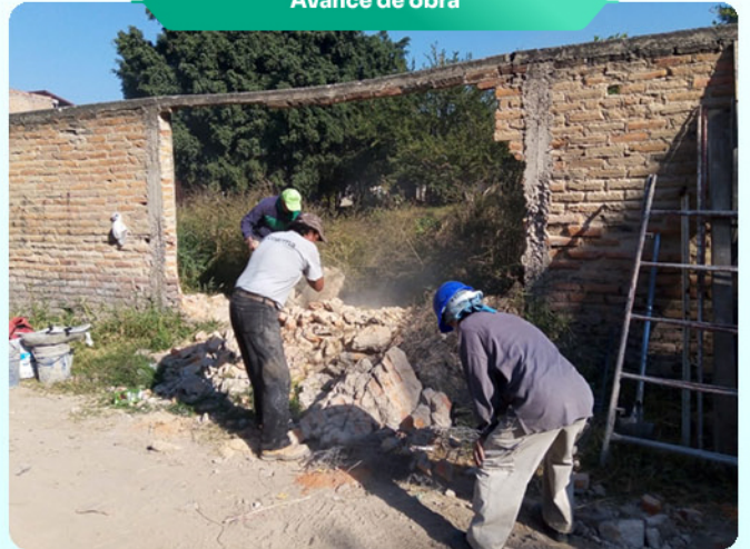
Avance de obra
