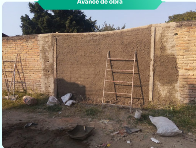
Avance de obra
